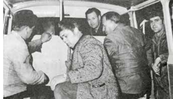
Karl Aagard, Rainer Kammel, Norbert Köhn, Otto Sommerfeldt und Dieter Persson arbeiten Anfang 1971 am Ausbau des ersten Heiligenhafener Krankenwagens.
