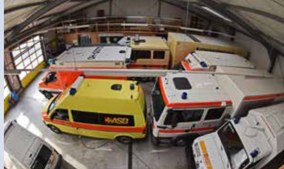
Blick in die Fahrzeughalle des Heiligenhafener ASB-Gebäudes aus der Fischaugensicht.
